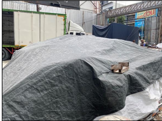
ภาพที่ 4 ผ้าใบปิดคลุมกองวัสดุก่อสร้าง
