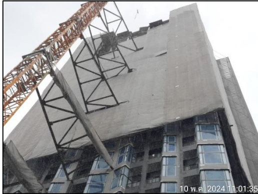
ภาพที่ 79 ผ้าใบ Mesh sheet ติครอบอาคารตลอดความสูง
